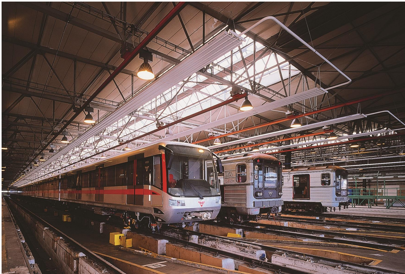
Депо метрополитена, г. Прага
