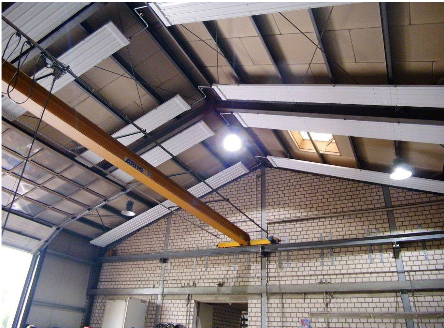
Складской комплекс, Германия
